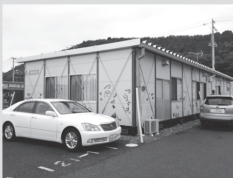
図10 石巻開成第二仮設団地北集会所
